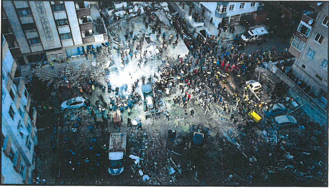
Şekil 4. 6 Şubat 2019 İstanbul'un Kartal ilçesinde çöken bina ve sonrası oluşan enkaz
