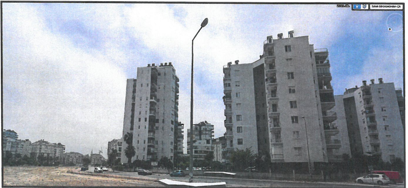
Şekil 4. 7273 ada 1 parsel güney cephesi mevcut bina kat sayıları
