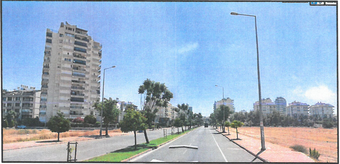
Şekil 6. 7273 ada 1 parsel kuzey ve doğu cephesi mevcut bina kat sayıları
