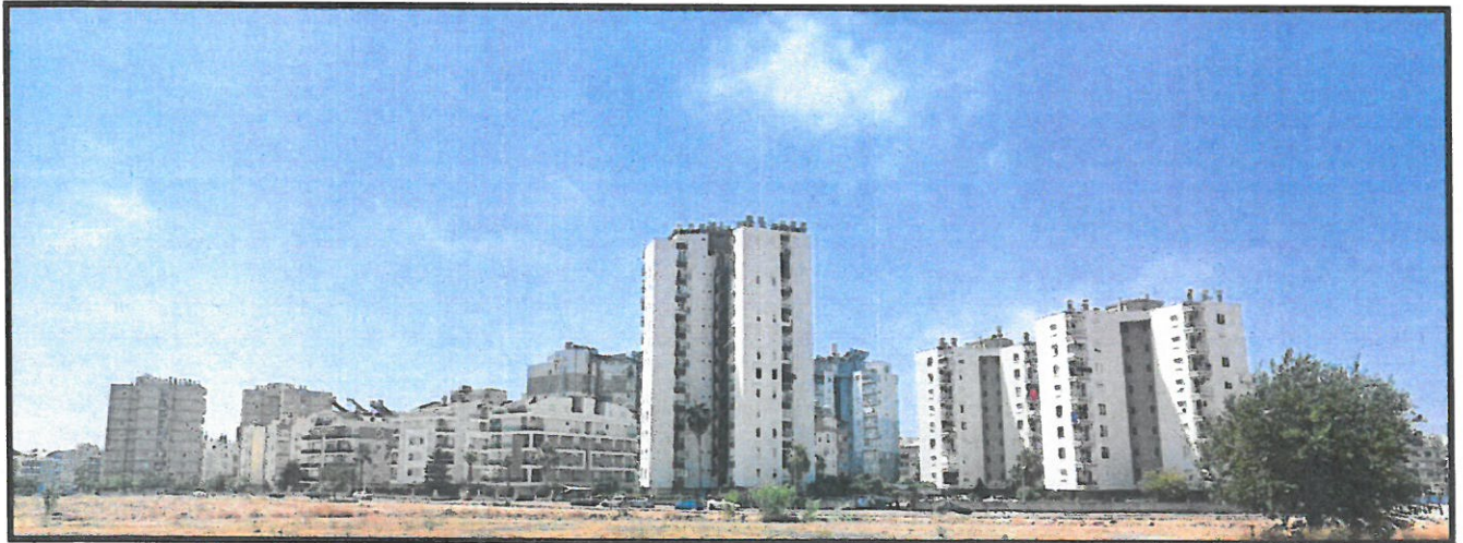
Şekil 7. 7273 ada 1 parsel güney cephesi mevcut bina kat sayıları
