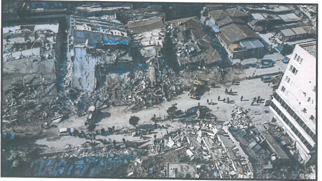
Şekil 10. 6 Şubat 2023 Kahramanmaraş Depremi Sonucu Enkaza Dönmüş Binalar.
