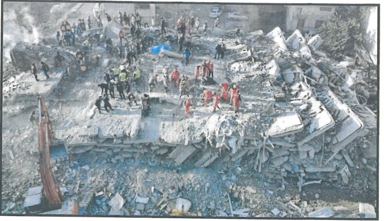
Şekil 9. 6 Şubat 2023 Kahramanmaraş Depremi Sonucu Enkaza Dönmüş Binalar.
