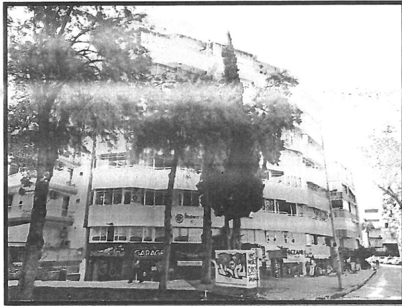
Suzan Apt (1 nolu) ve Ekin Apt (33 Nolu) Yapı Durumu
